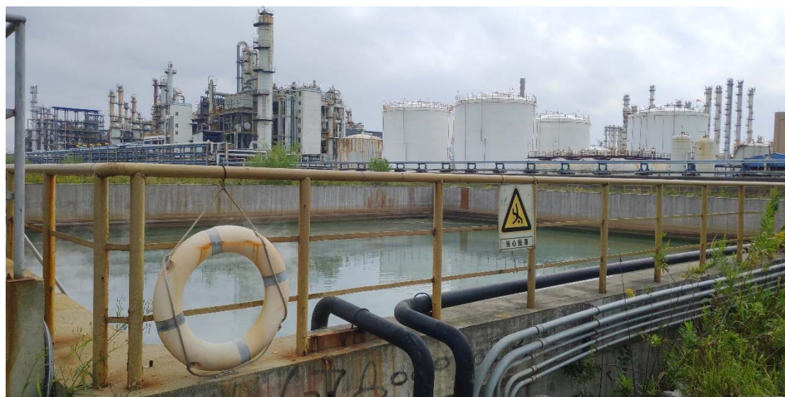
图 2.3-3 北厂事故水池
