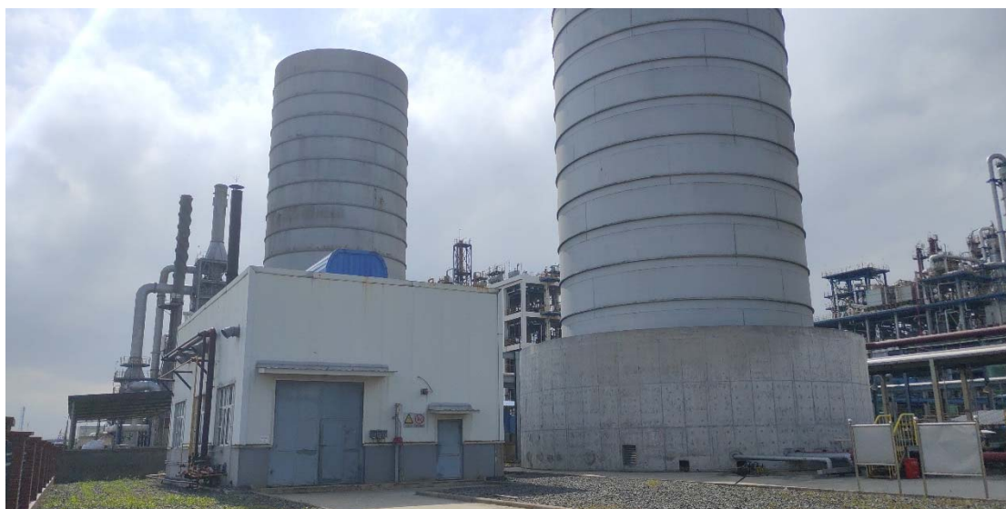
图 2.3-1 北厂废气焚烧炉房及地面火炬
